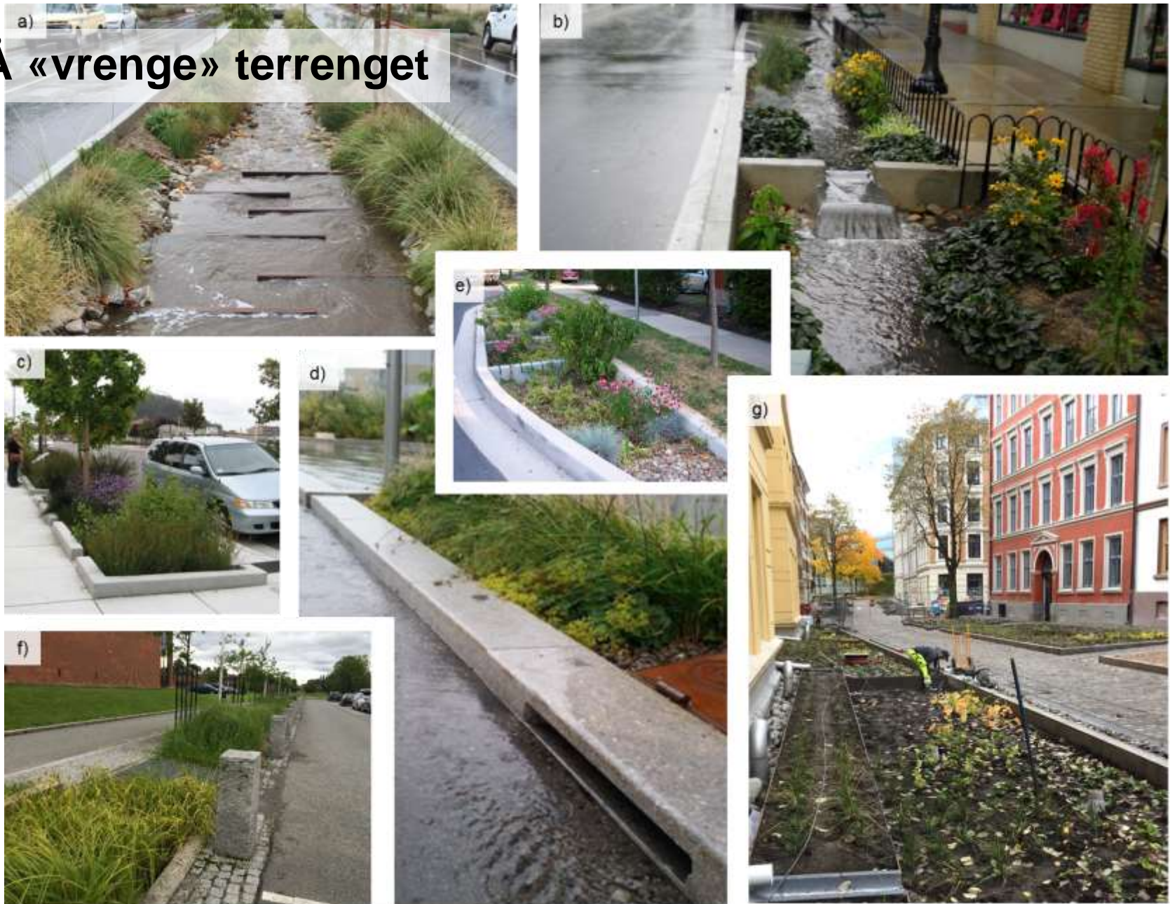
Eksempler på åpen og blågrønn håndtering av overvann ved gate. a) Seattle (foto: SVR Design Company), b) Allen Street, Pennsylvania, USA (foto: State college Pennsylvania), c) City of El Cerrito, San Francisco, USA (foto: City of El Cerrito), d) Ensjør, Oslo (foto: Vann og avløpsetaten), e) Bernhard Street, Pennsylvania, USA (foto: State college Pennsylvania), f) Risenga bad, Asker (foto: K.H. Paus), g) Regnbed i Deichmans gate, Oslo (foto: K.H. Paus)
